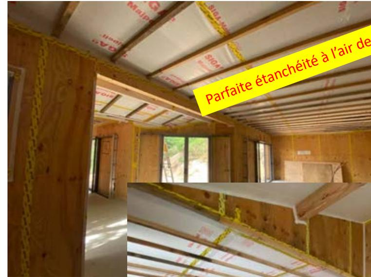
Parfaite étanchéité à l'air des panneaux
